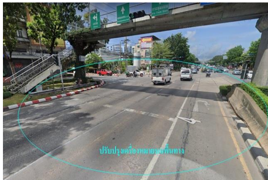
ภาพก่อนดำเนินการ
